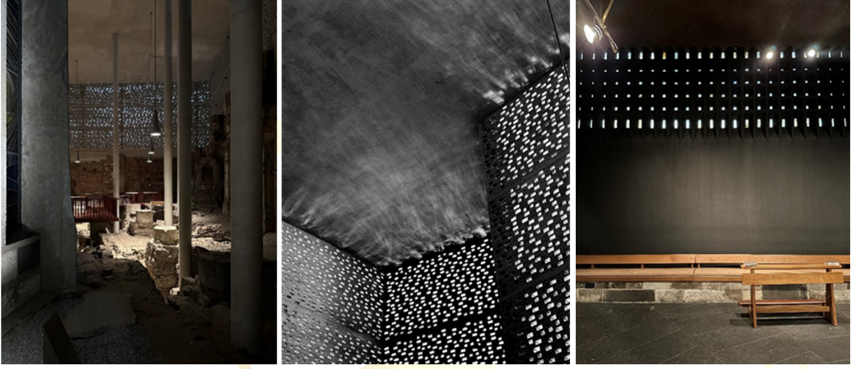
Şekil 9. Yapının ışık-gölge dengesini sağlayan “filtre duvar” olarak isimlendirilebilecek duvar örgüsü (Akşehirlioğlu, 2024)
